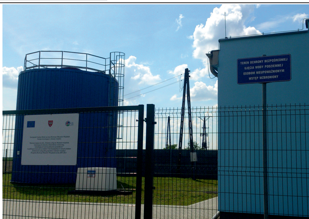
Zmodernizowana stacja uzdatniania wody w Czachulcu Starym
